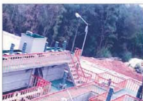
酒廠廢水處理
