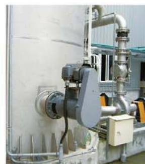
側插桶槽(單卡夾+格蘭軸封)
